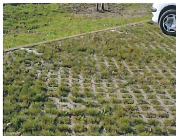
pavés béton à joint engazonné
