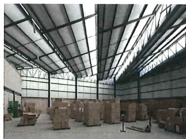
Exemple d'éclairage zénithal / sheds
